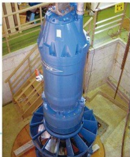
点検のため、引き揚げた水中タービン発電機
