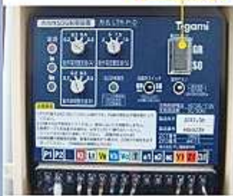
方向性地絡継電器の一例
