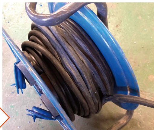
被覆が溶けたコードリール
